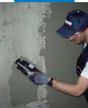
Nanášení Planitopu 200 na betonový podklad
